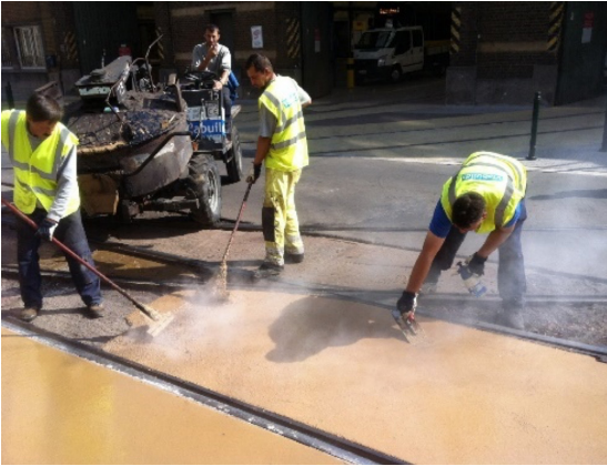
Figuur 3 – Aanleg van okerkleurig gietasfalt (© Viabuild)
