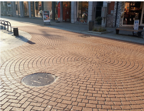
Figuur 4 – Gekleurd asfaltbeton voorzien van een print
