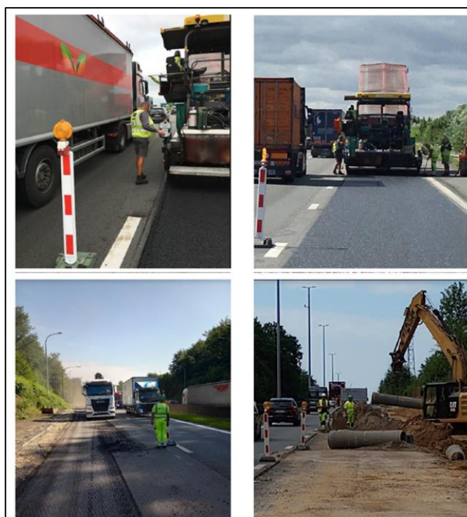
Figure 25 – Utilisation de la bande de sécurité pendant les travaux (Source : Vias, AWW)
